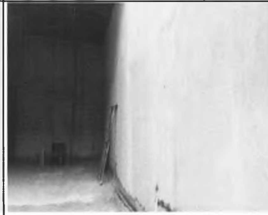
EXECUÇÃO DE REVESTIMENTO DE PAREDES - REBOCO
