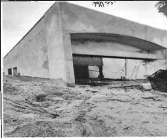
EXECUÇÃO DE REVESTIMENTO DE PAREDES - REBOCO
