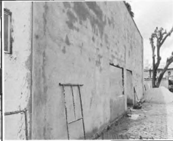
EXECUÇÃO DE REVESTIMENTO DE PAREDES - REBOCO
