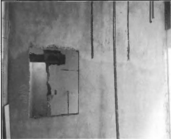
CORTE EM PAREDES PARA PASSAGEM DE TUBULAÇÃO ELÉTRICA
