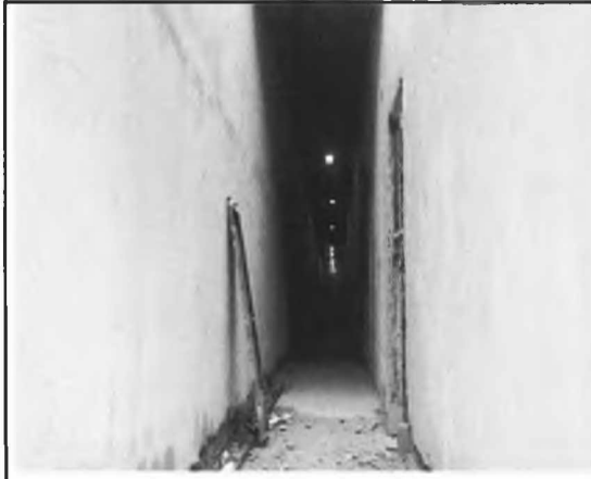
EXECUÇÃO DE REVESTIMENTO DE PAREDES - REBOCO
