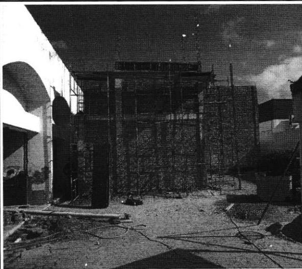
EXECUÇÃO DE PAREDES E ESTRUTURA DE CONCRETO
