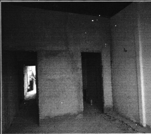
EXECUÇÃO DE REVESTIMENTO DE PAREDES - REBOCO
