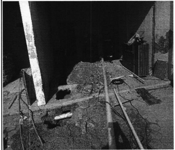
INSTALAÇÃO DE TUBULAÇÕES HIDRO-SANITÁRIAS
