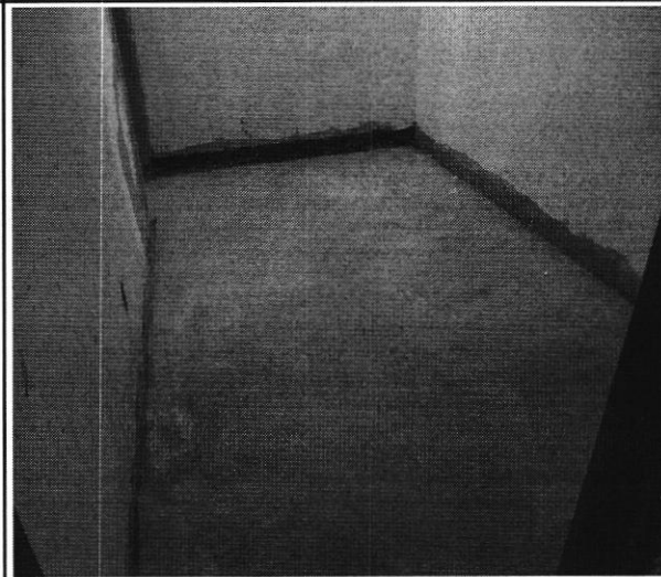
EXECUÇÃO DE PISO EM CONCRETO
