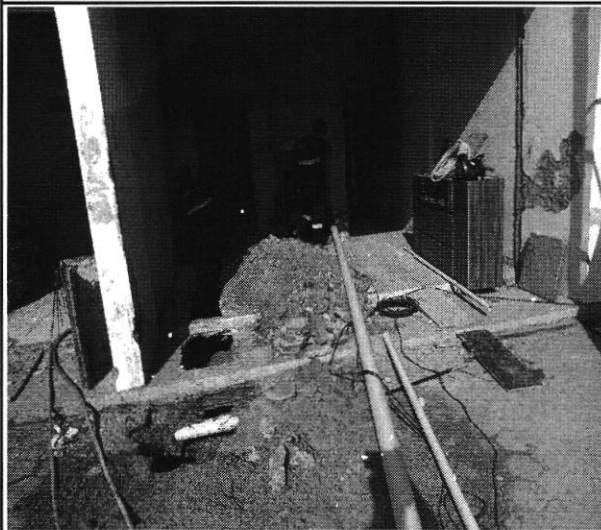
INSTALAÇÃO DE TUBULAÇÕES HIDRO-SANITÁRIAS
