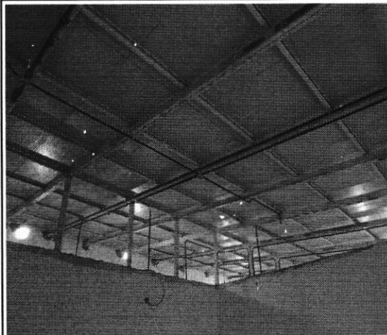
INSTALAÇÃO DE TUBULAÇÕES E ACESSÓRIOS ELÉTRICOS
