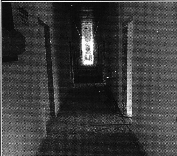
EXECUÇÃO DE PINTURA EM PAREDES
