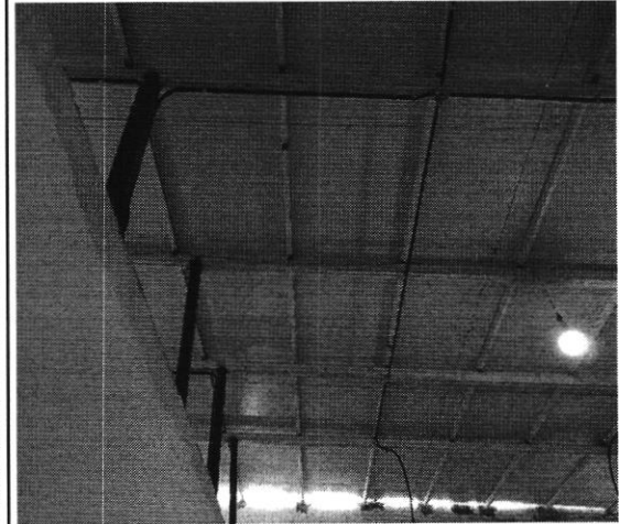
INSTALAÇÃO DE TUBULAÇÕES E ACESSÓRIOS ELÉTRICOS
