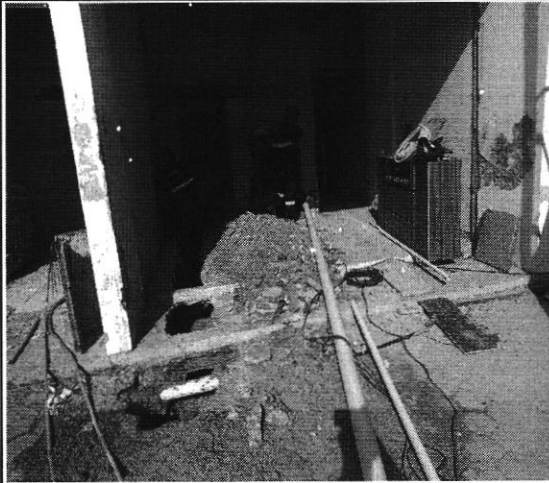
INSTALAÇÃO DE TUBULAÇÕES HIDRO-SANITÁRIAS
