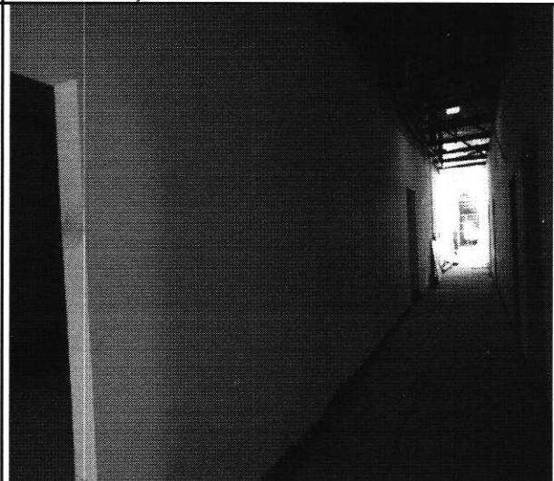
EXECUÇÃO DE PINTURA EM PAREDES
