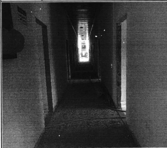
EXECUÇÃO DE PINTURA EM PAREDES
