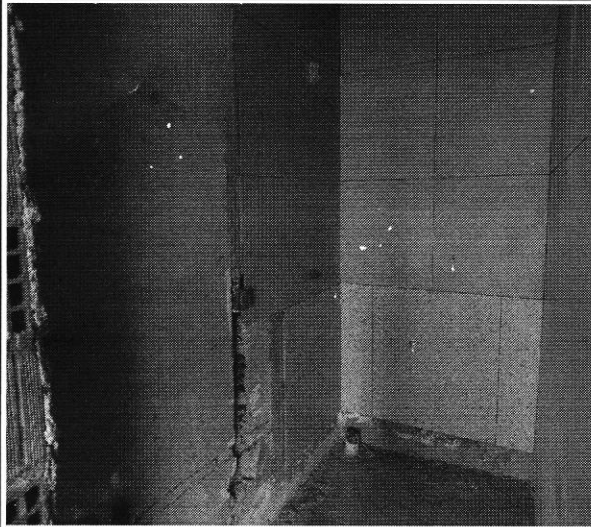
EXECUÇÃO DE REVESTIMENTOS INTERNOS DE PAREDE
