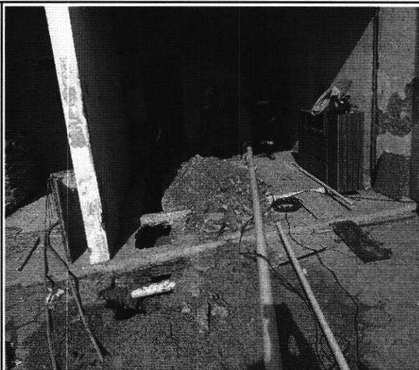
INSTALAÇÃO DE TUBULAÇÕES HIDRO-SANITÁRIAS
