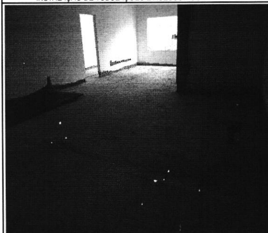
EXECUÇÃO DE PISO EM CONCRETO
