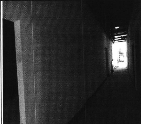
EXECUÇÃO DE PINTURA EM PAREDES
