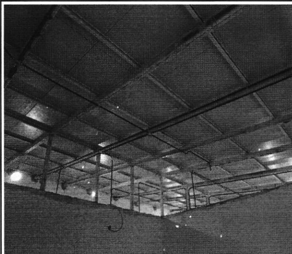
INSTALAÇÃO DE TUBULAÇÕES E ACESSÓRIOS ELÉTRICOS
