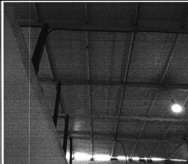
INSTALAÇÃO DE TUBULAÇÕES E ACESSÓRIOS ELÉTRICOS
